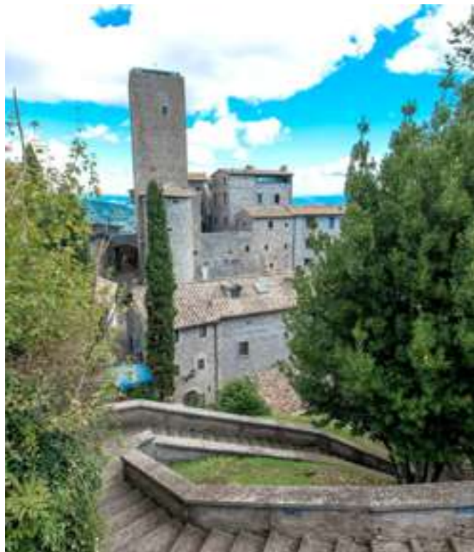
La Torre dell'Orologio e il campanile della chiesa di Santa Maria dei Lumi The Clock Tower and the bell tower of the church of Santa Maria dei Lumi
